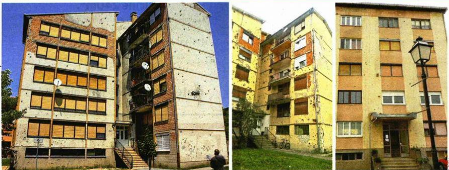
Primjeri zgrada koje su u upravu odobrenih sredstava energetske obnove. Uskoro po obnovu zgrade u Hebrangovom trgu 2 u Pakracu (sasvim lijevo) zgrade u Slavonskoj ulici u Vukovarskoj ulici u Lipiku
