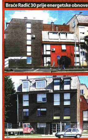
Brće Radić 30 prije energetske obnove
